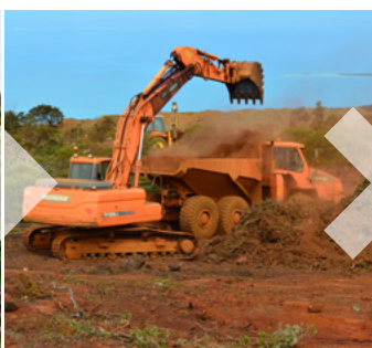
Défrichage et récupération du topsoil
