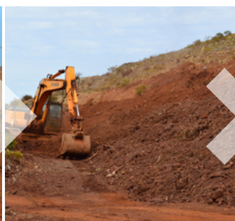
Épandage sur versant du topsoil
